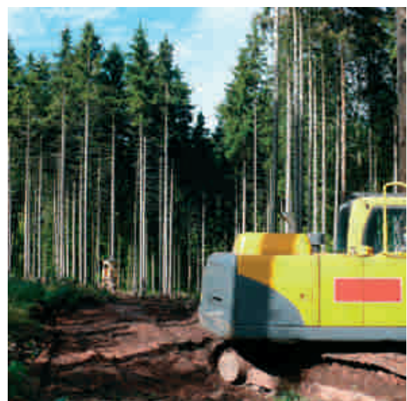
Wegebau im Südharz | Foto: Lutz Döring
